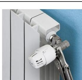
**4** - Avvitare la ghiera metallica zigrinata della testa termostatica, sul corpo valvola fino al suo bloccaggio. Dopo il montaggio della testa, ruotare alcune volte la manopola numerata, da posizione "5" a posizione "\*", per un assetamento delle parti.
